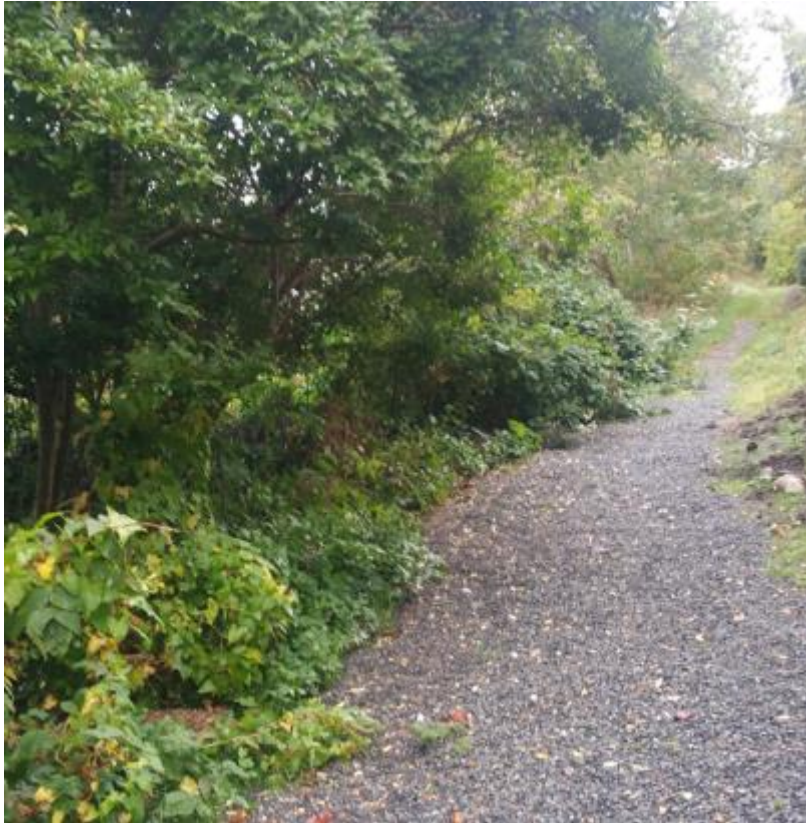
Figur 17. Bild från platsbesök utmed gångstråk där även spillvattenledningen är förlagd (Foto: Mikael Van Der Hoogen)
