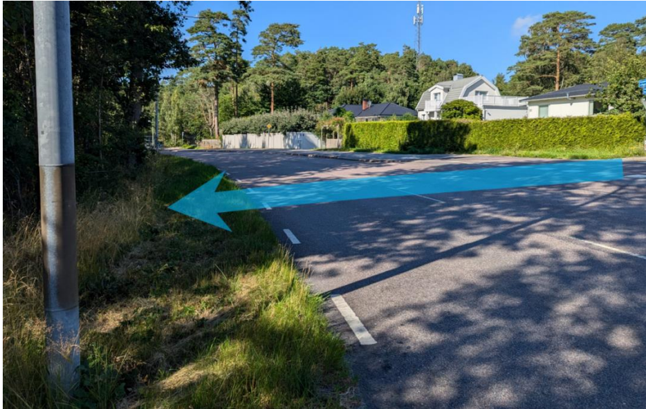
Figur 43. Gamla Särövägen. Skyfallsflöden från Askims Röseväg (höger om bild) behöver ledas in mot planerad parkering. (Foto: Petter Mogenfelt)
