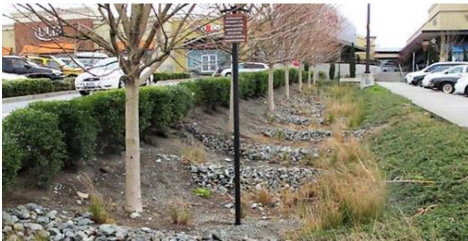
Figur 62. Exempel på svackdike med stenvallar som sänker flödes hastigheten (Foto: Mary Lou Smith)
