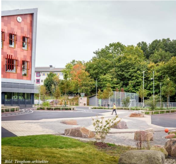
Figur 58 Dagvatten- och skyfallshantering på skolgård samt upphöjd entré till skolbyggnad.
