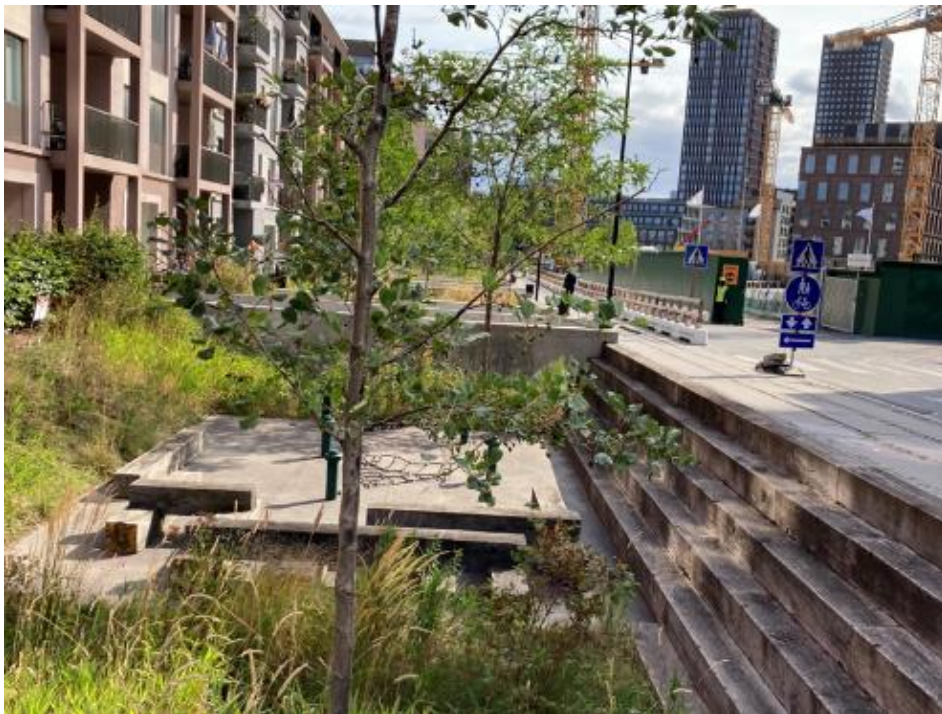
Figur 50. Nedsänkt yta för dagvatten-/skyfallshantering i Köpenhamn (Foto: Kretslopp och vatten)
