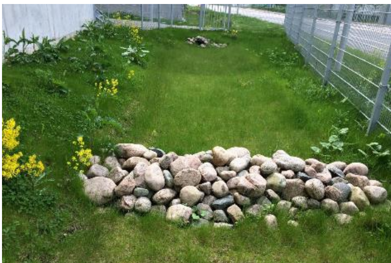
Figur 74. Svackdike med dämmande stenvall på Alelyckan, Göteborg (Foto: Kretslopp och vatten)
